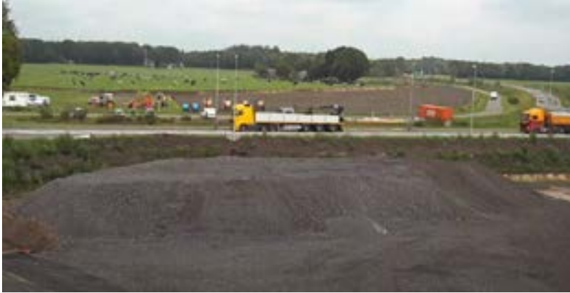
Aanbrengen ophoogmateriaal knooppunt Varsen
