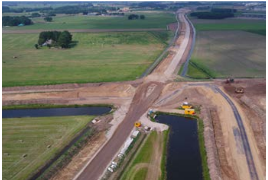
Verticaal het nieuwe tracé van de N340, dat op deze locatie de Bese kruist met een viaduct óver de N340 heen.
