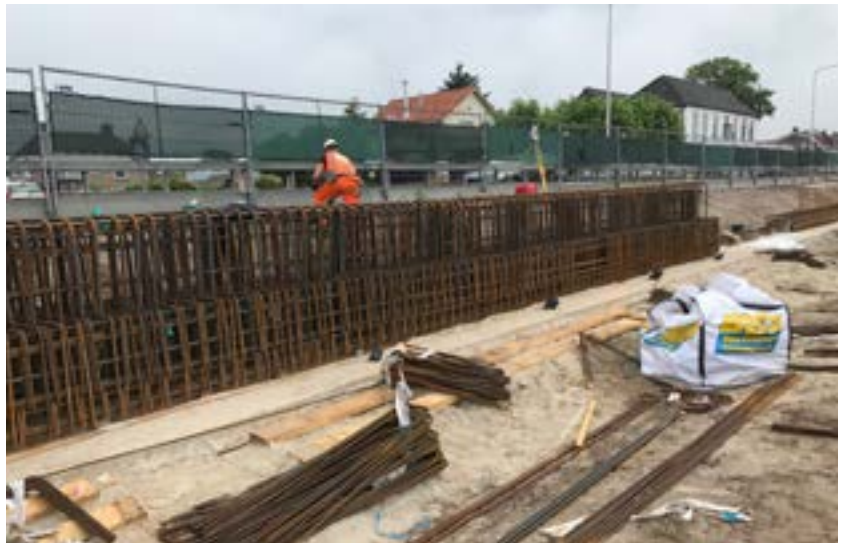
Balkbrug - Aanbrengen bewapening betonconstructie
