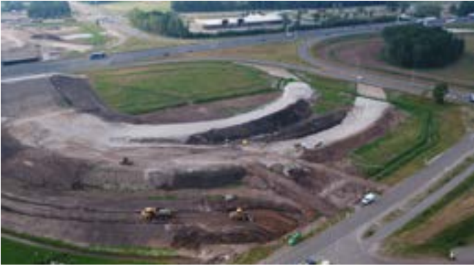
De nieuwe aansluiting van de A28 op de N340.
