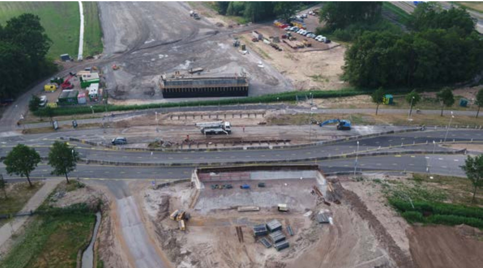
De twee landhoofden voor het viaduct over de Nieuwleusenerdijk.
