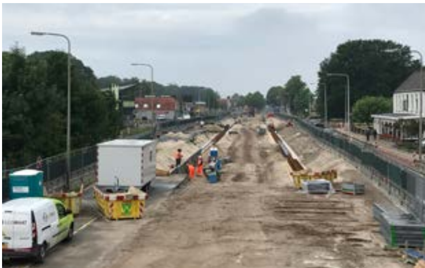
Balkbrug - Voorbereidende werkzaamheden ontgraven bouwkuip onderdoorgang Balkbrug
