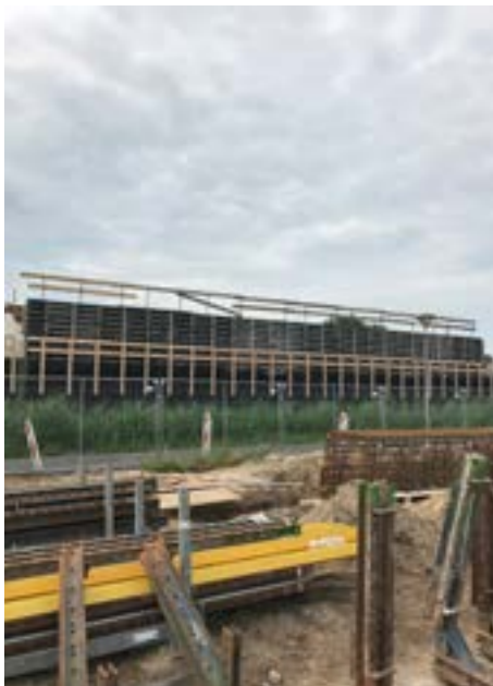
Hessenpoort - Werkzaamheden aan het landhoofd van het viaduct over de Nieuwleusenerdijk
