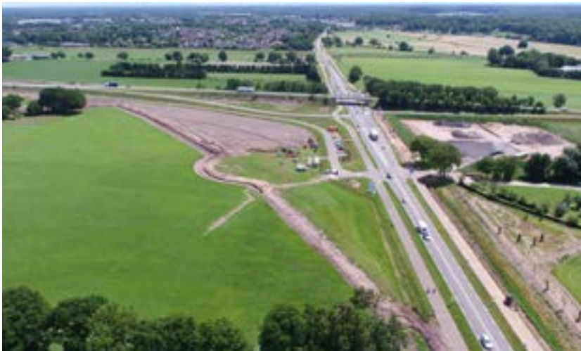
De nieuwe verbinding tussen de N340 en de N48 is al zichtbaar in het gras.
