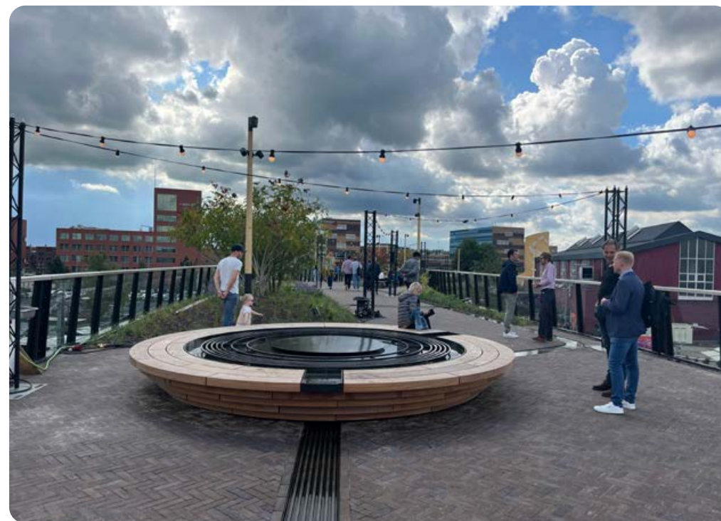
De Passarelle, een duurzame houten voetgangersbrug, verbindt het centrum van Zwolle met de spoorzone. De nieuwe loopbrug is een park op hoogte, een fijne plek om te verblijven. De CO 2 -uitstoot van de houten Passarelle is ruim 70% lager dan een vergelijkbare voetgangersbrug.
